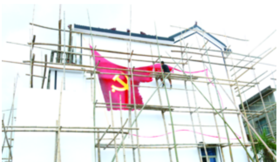
为配合“国际慢城”建设,渣瀨湾村加快对农房外立面整改,预计今年9月底全部完工。图为8月23日,记者在紫港街道渣瀨湾村看到的情景。见习记者 汪东丽 摄
